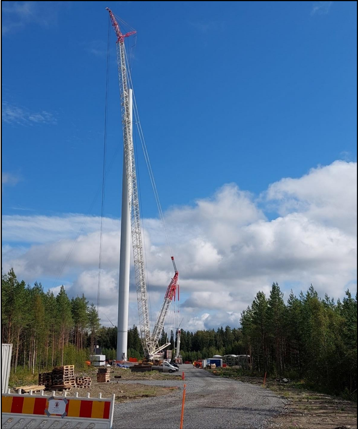
Kuva 4-8. Esimerkkikuva tuulivoimalan pystyttämisestä (Prokon Wind Energy Finland Oy).
