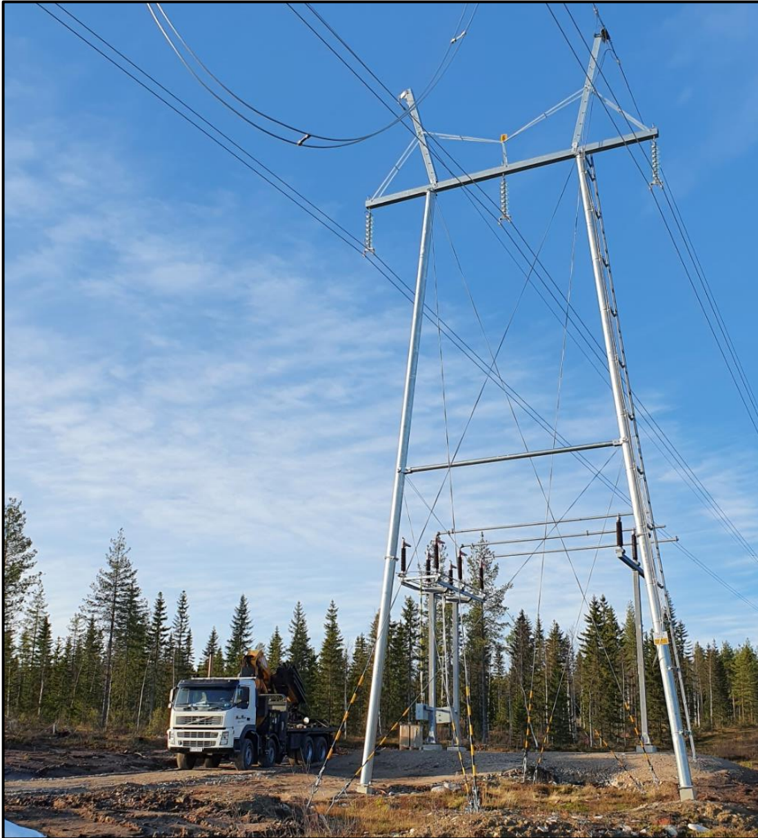
Kuva 4-9. Esimerkkikuva pystytetystä voimajohtopylvästä (Prokon Wind Energy Finland Oy).
